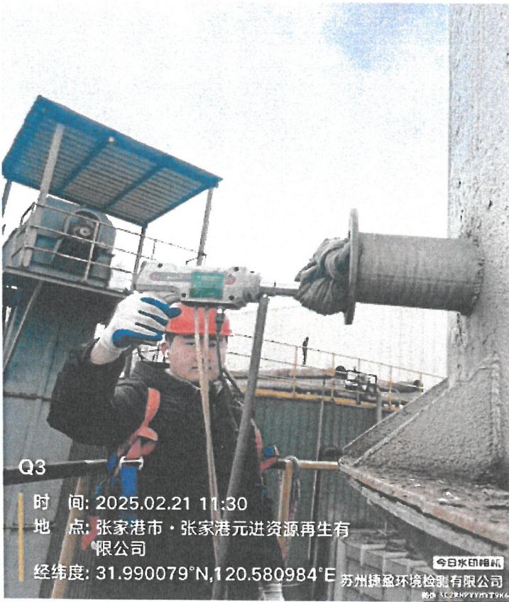
采样点位：排气筒 3#出口 Q3
