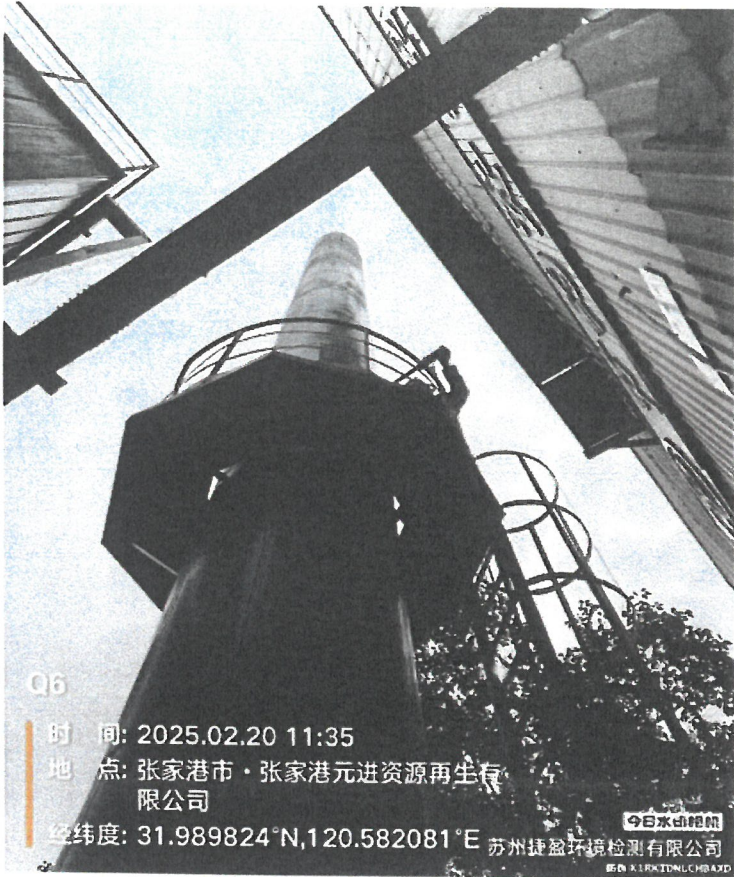
采样点位：排气筒 6#出口 Q6
